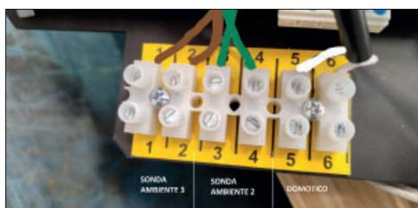
En cas de connexion de sondes ou de thermostats sur les entrées ambiance, les paramètres correspondants doivent être configurés dans le Menu techniq de l'appareil.
